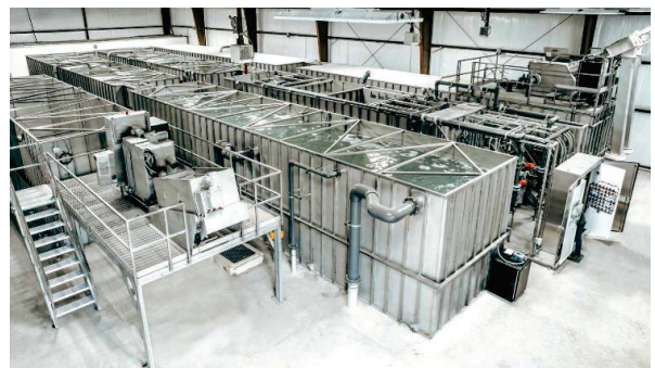
Cloacina MEMPAC-M installation
